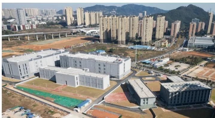
公司长沙数据中心
