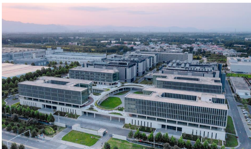
公司北京房山数据中心
