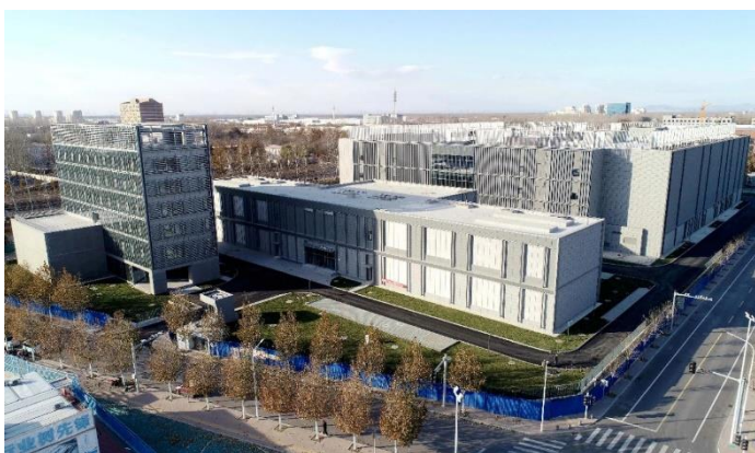
公司天津宝坻数据中心
